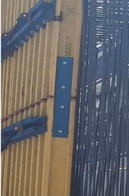
H20-H20 Birleştirme Elemanı Bağlantı Detayı H20-H20 Connection Element Detail
